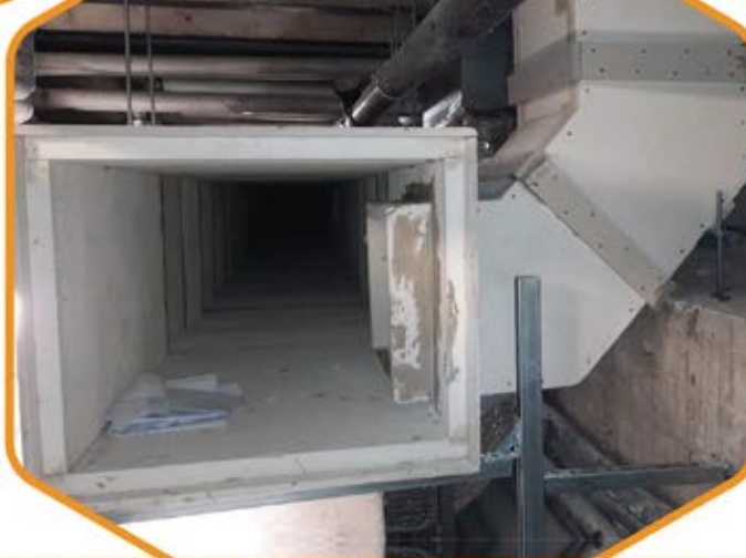
Innesto da Orizzontale a Verticale con curva 90°
