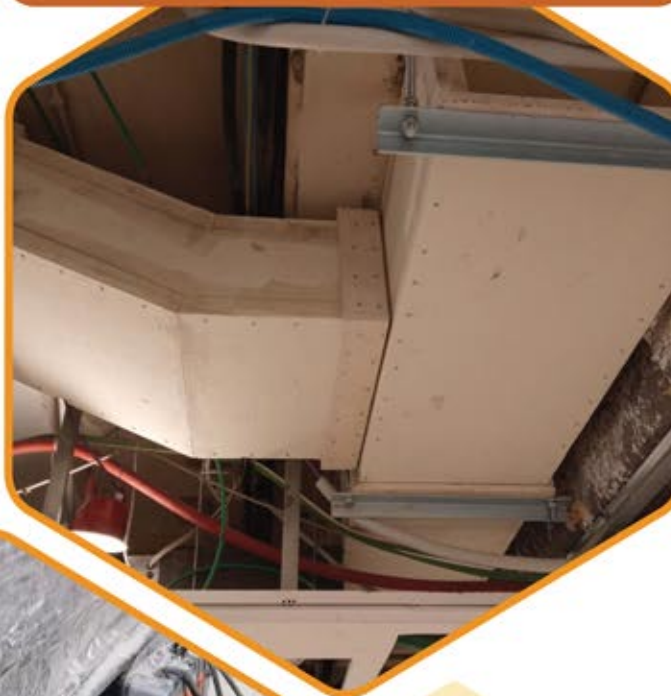
Innesto Laterale da Dislivello
